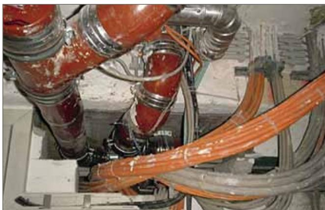
*Einbau eines Kombischotts? Hier ist keine fachgerechte Ausbildung eines Kombischotts mehr möglich.*
