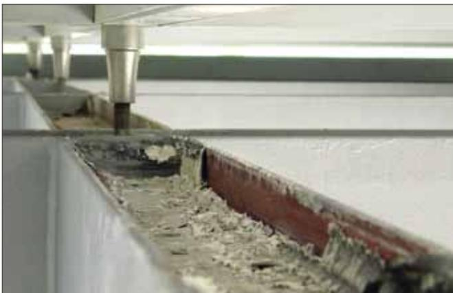
Mangelhafte Stahlbeschichtung nach andauernder Wasserbeaufschlagung.
