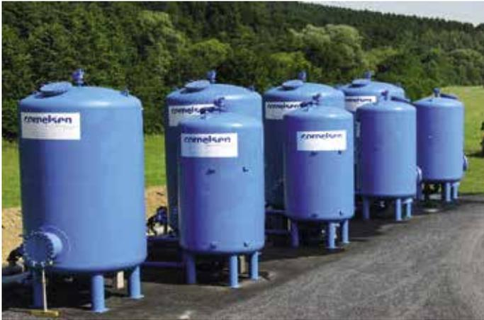
Abb. 4: Beispiel einer großvolumigen Aktivkohleanlage für die Behandlung von PFC-verunreinigtem Wasser.
