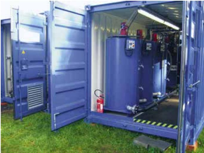
Abb. 6: Grundwassersanierungsanlage der Cornelsen Umwelttechnologie GmbH auf dem Flughafen Nürnberg
